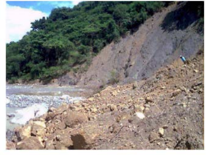
Regresión por derrumbe
